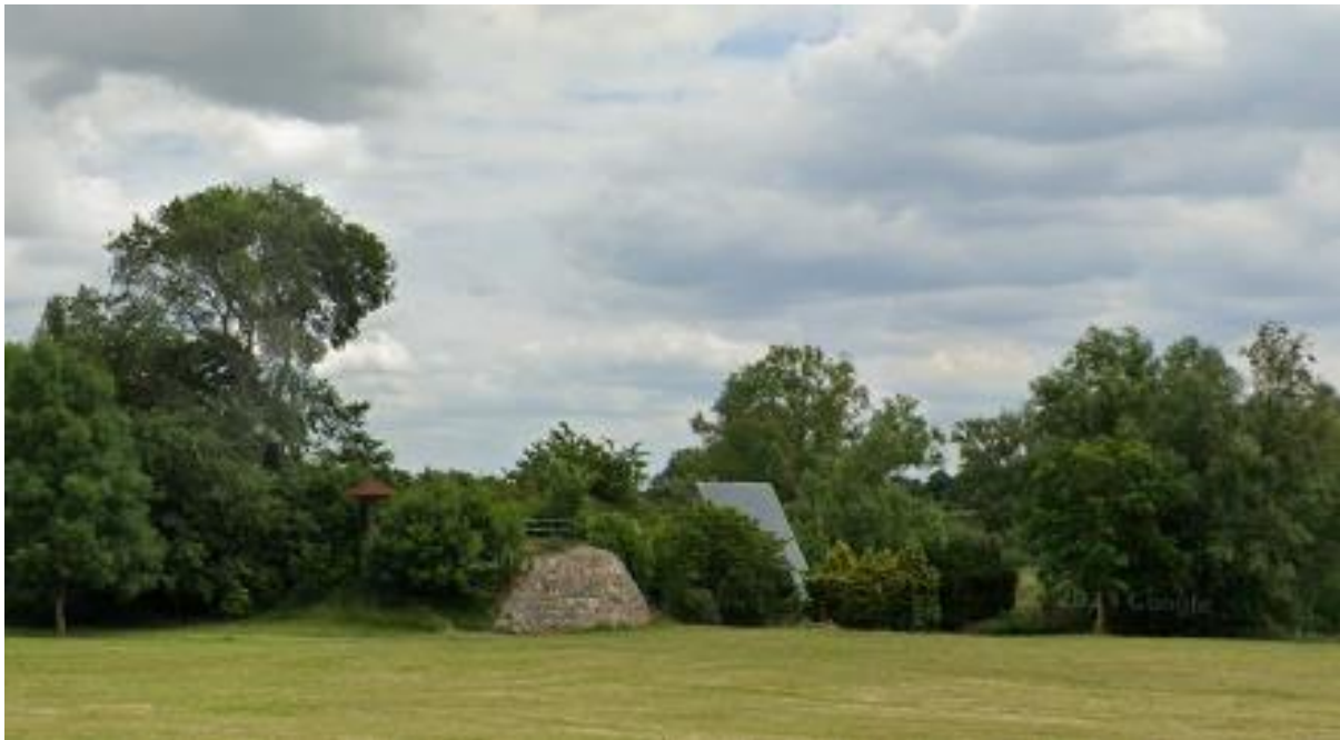
Bild 05 Findlingsmauer, Artenschutzhaus außerhalb der Bauflächen, Erhaltung
