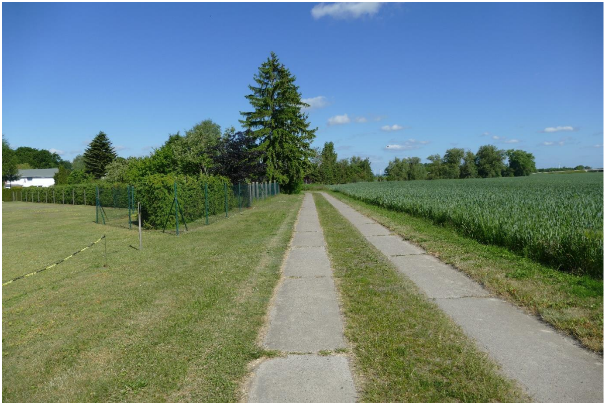
Bild 07: Teilversiegelter Wirtschaftsweg nördlich Teilgebiet Hofstraße
