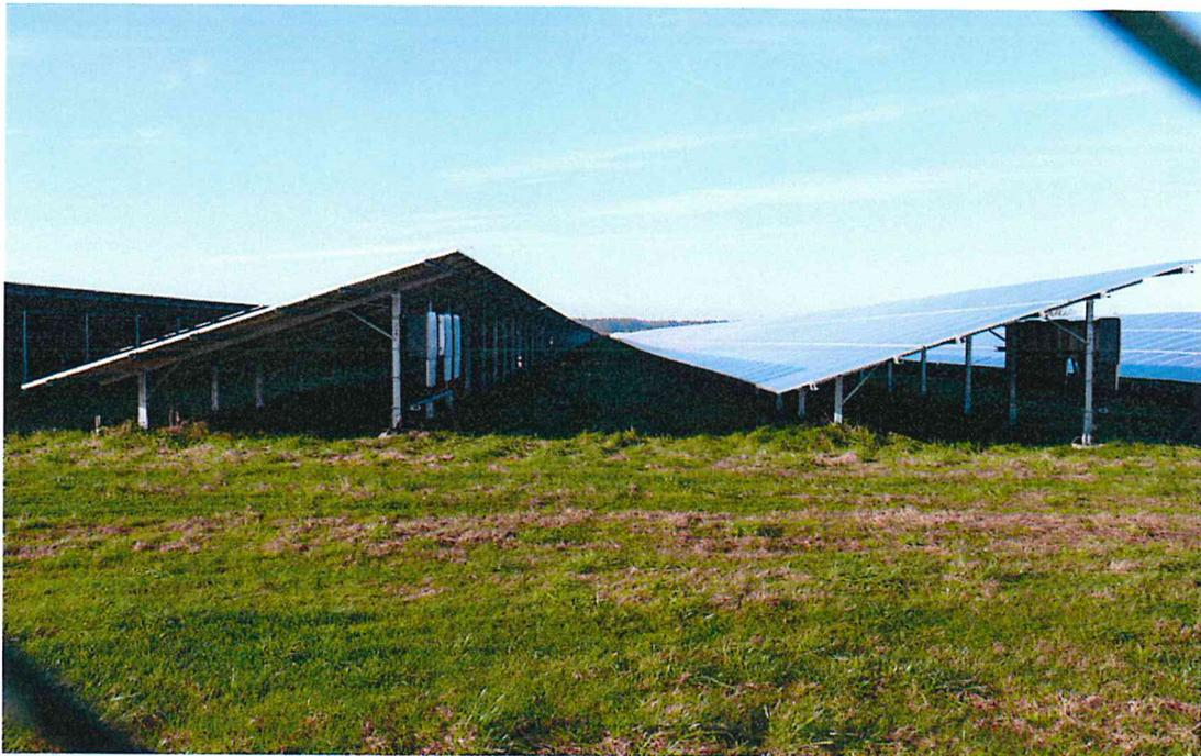
Abbildung 2: Beispiel für mehrreihige Modultische. Fot: SLF 28.10.2014.
