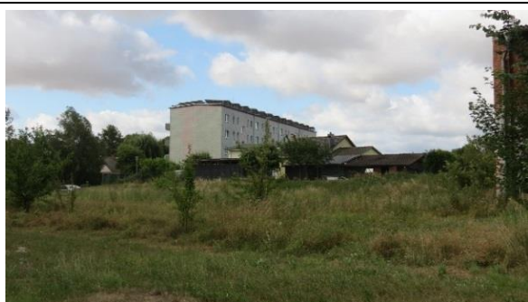
Blick von der Schlosstraße in Richtung Westen
