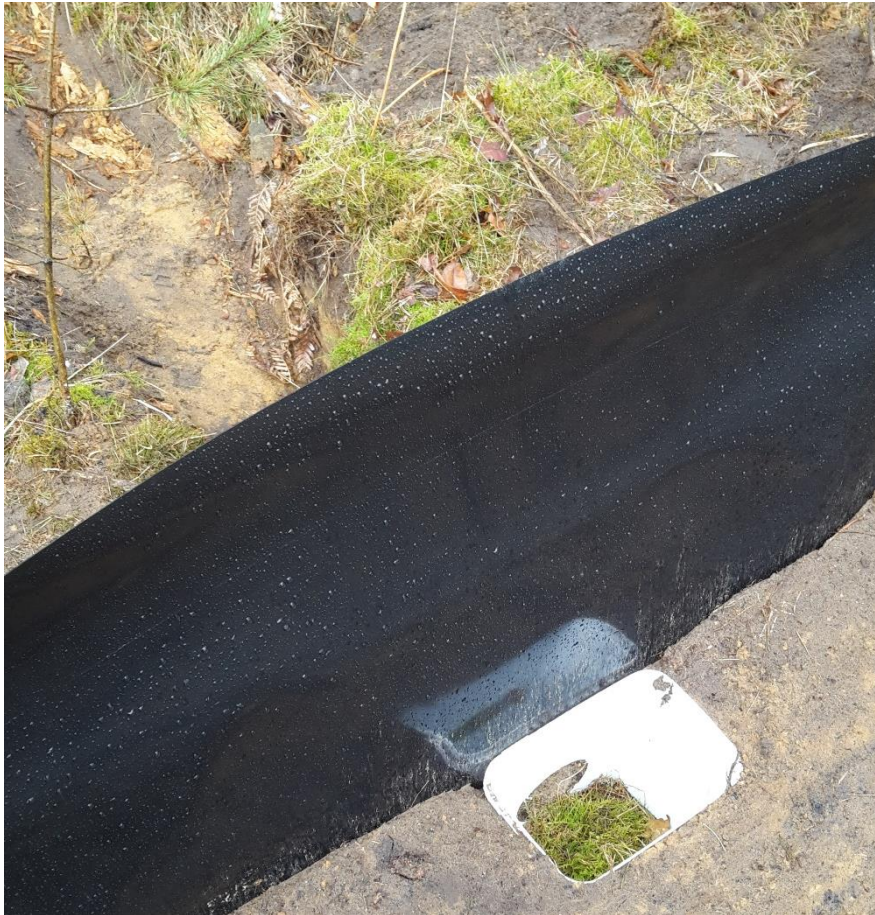
Abb. 9: Beispiel für einen Reptilien-Schutzzaun, welcher das Baufeld umschließt und durch Fangemier ergänzt wurde. Durch eine Öffnung nach außen können Reptilien in das angrenzende Habitat gelangen, jedoch nicht zurück auf das Baufeld.
